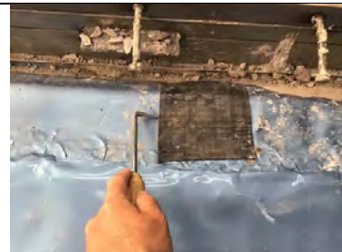
Patch repair using Juta GP1 SAM.
