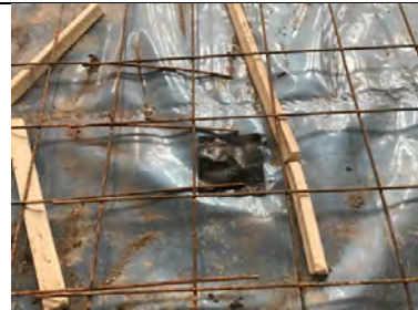
Repaired damaged membrane using Juta GP1 SAM.
