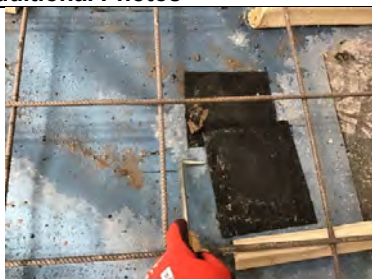
Probe testing a Juta GP1 SAM CQA repair.
