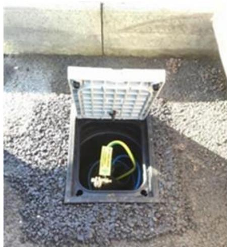
FIGURE 3: LOCALIZED TT EARTH SPIKE
